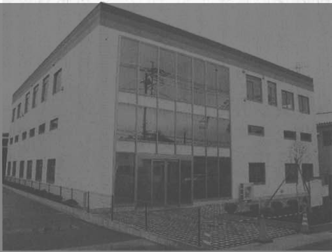
新設した第3工場棟
